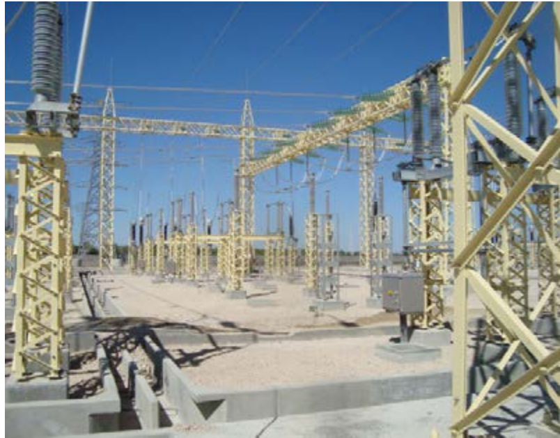
CONSTRUCCION DE LA OBRA CIVIL CIMENTACIONES MAYORES Y MENORES DEL PROYECTO CFE PIF-014/2011 S.E. GUERREÑO
