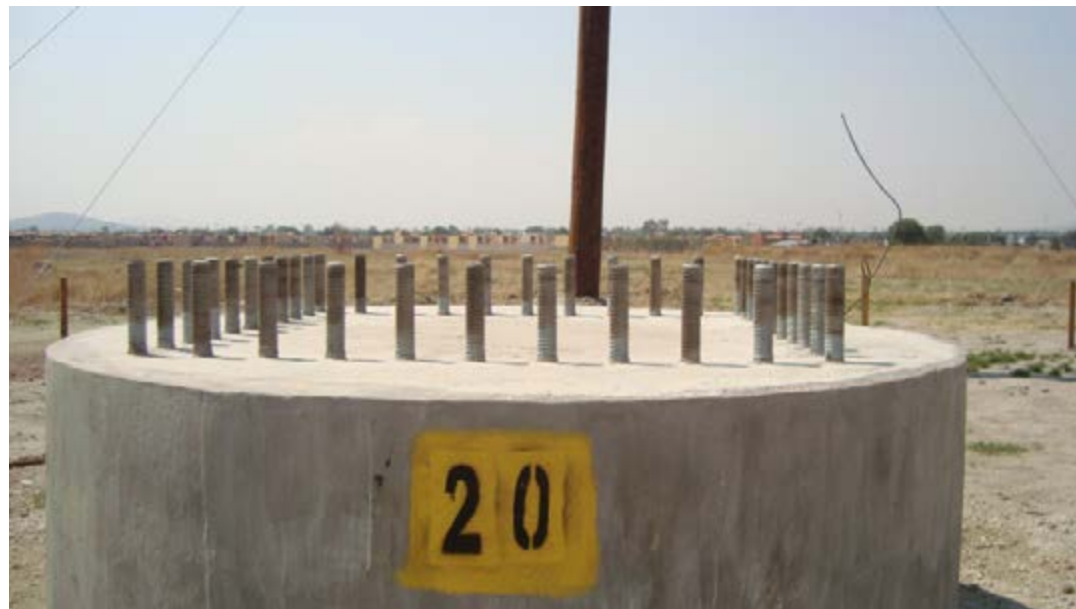
INSTALACION DE POSTES TRONCOCONICOS DE 230 kV Y DESMATELAMIENTO DE LINEA PROVISIONAL DE POSTES DE MADERA DEL PI-5 AL PI-11 DE LA LT. TECAMAC ENTRONQUE
