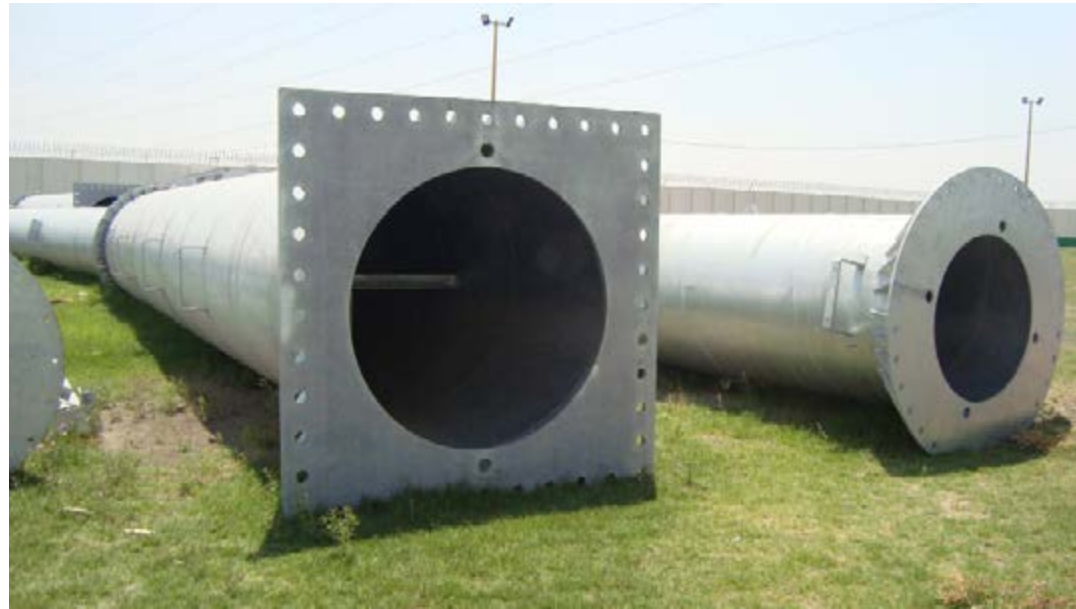
INSTALACION DE POSTES TRONCOCONICOS DE 230 kV Y DESMATELAMIENTO DE LINEA PROVISIONAL DE POSTES DE MADERA DEL PI-5 AL PI-11 DE LA LT. TECAMAC ENTRONQUE
