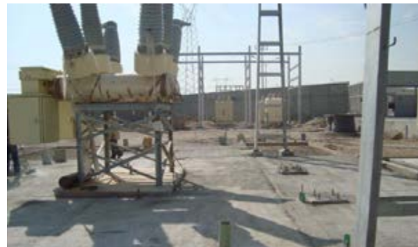
CONSTRUCCION DE LA S.E VILLA DE GARCIA DE LA ZONA METROPOLITANA PONIENTE
